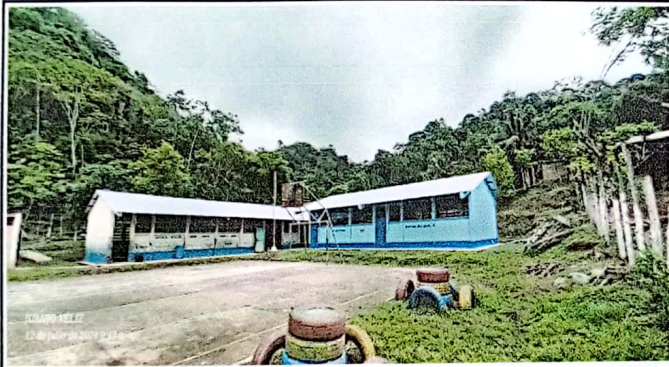
Foto 3: Sustitución de estructura
