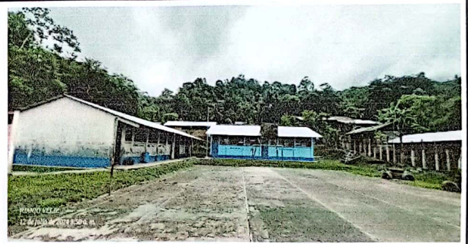
Foto 4: Sustitución de estructura
